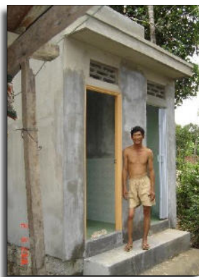
Un nuovo impianto con WC e doccia. Costi: da CHF 100.- fino a 150.-
