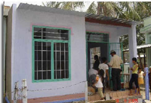
... e dopo. La ristrutturazione è stata finanziata dall'Associazione in ragione del 100%.
