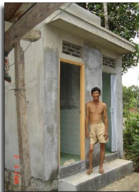
Ein neuer Sanitärblock mit WC und Dusche. Kosten ca. CHF 100 - 150.-
