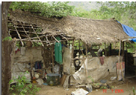
Die baufällige Behausung einer Familie vorher...
